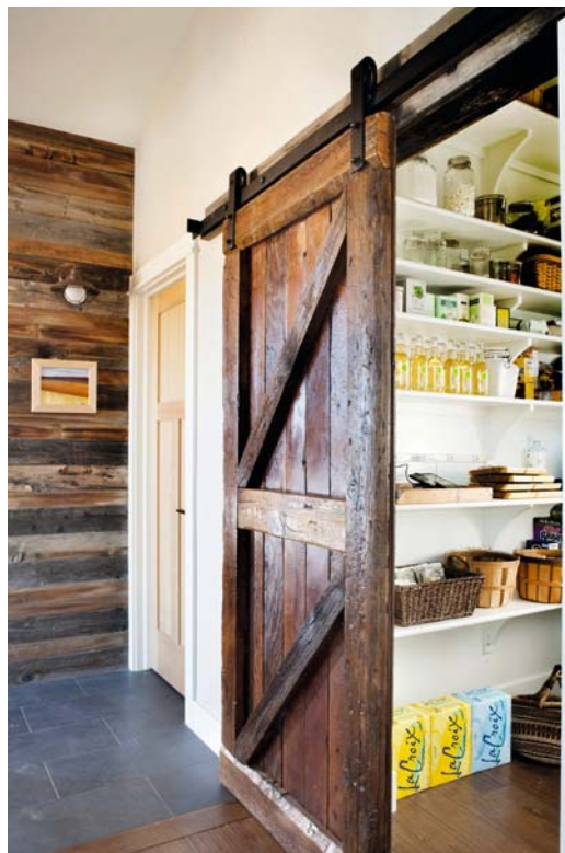
Stare drzwi zamontuj na szynie. Zyskasz nie tylko metry, ale i ciekawy efekt w domu.
